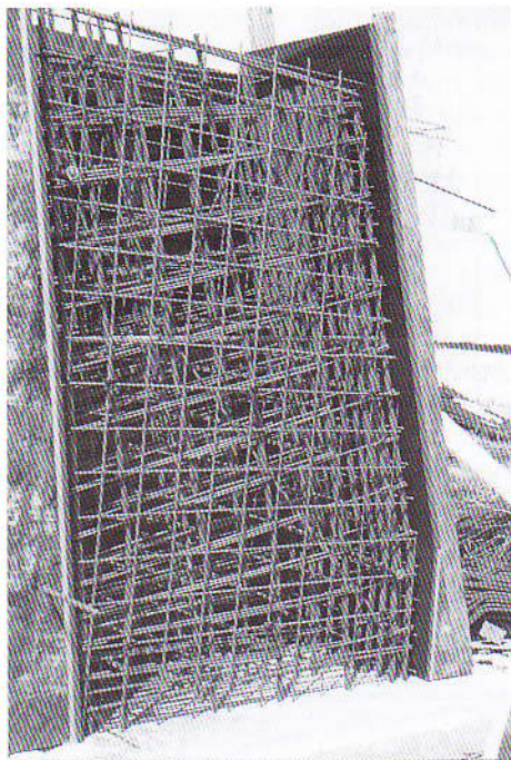
Rys. 3. Zbrojenie i deskowanie elementów badawczych
