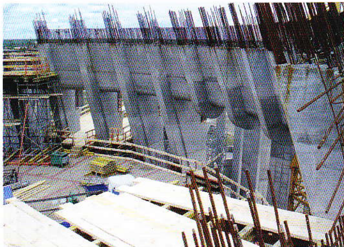
Rys. 10. Ściana tarcza nad prezbiterium o wysokości 2,2 m
