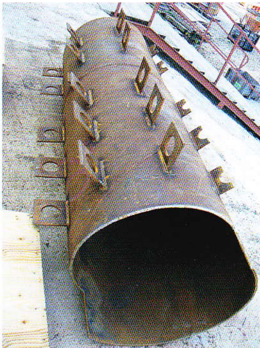
Rys. 9. Widok rury stalowej zastosowanej w wieńcu wewnętrznym
