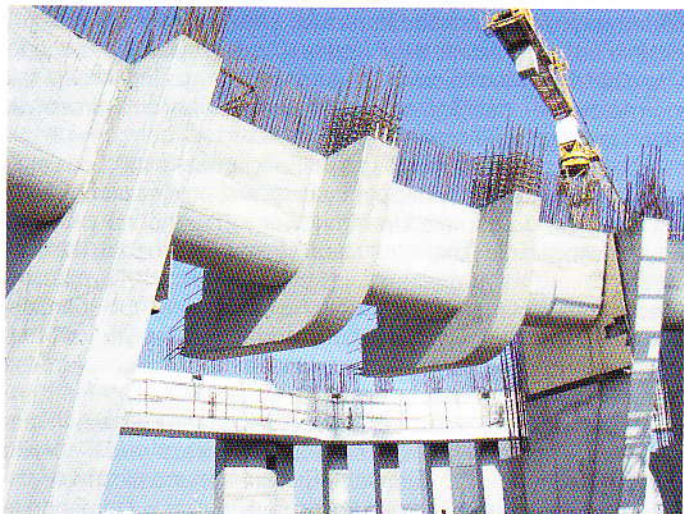
Rys. 13. Rygle nad stropem chóru
